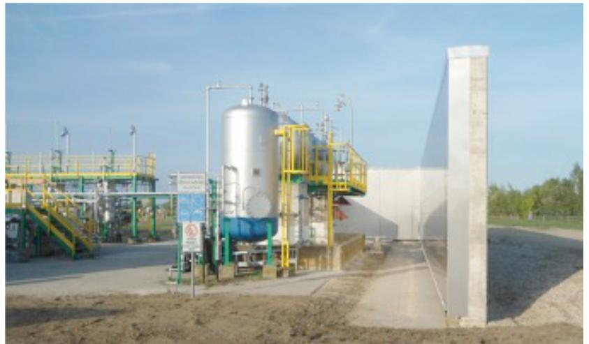
Figura 9 - Esempio di barriera di sicurezza installata
