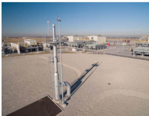
Figura 5 - Stabilimento Stogit di Bordolano (CR) - Impianto di blow-down di centrale
