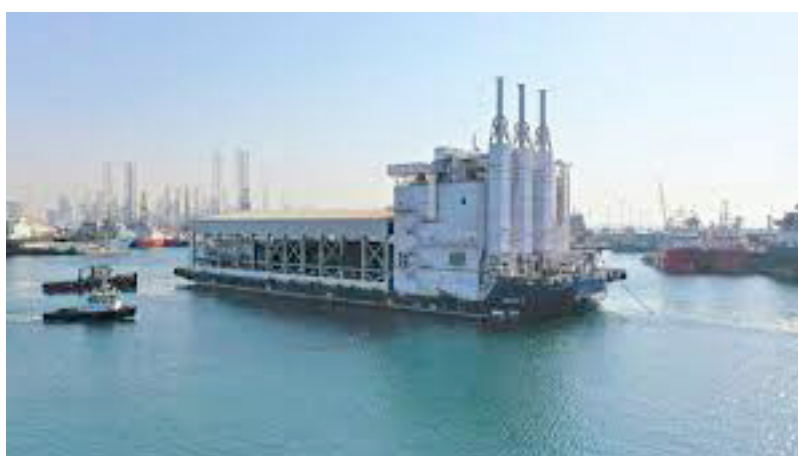
Impianto di dissalazione mobile su nave, Arabia Saudita
