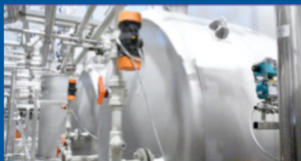
Dettaglio dell'attuatore pneumatico "PPA" e della valvola "546 Pro", completamente realizzati in materiale plastico
