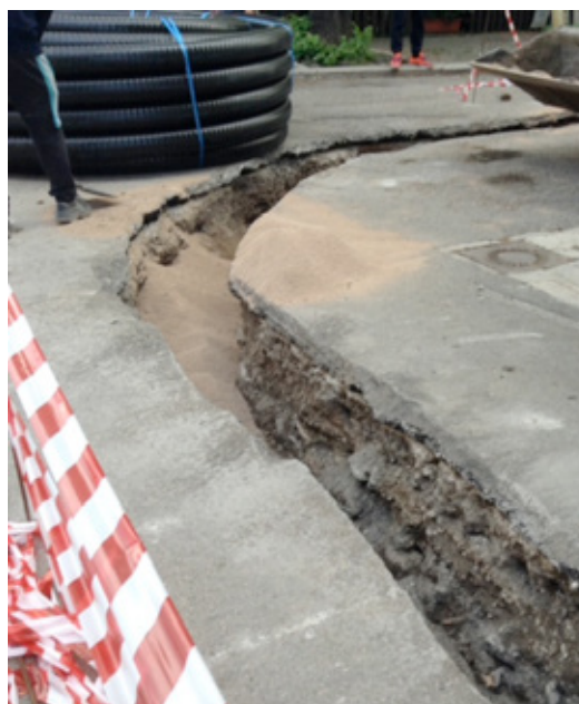
Il ridotto raggio di curvatura testimonia la grande flessibilità della tubazione
