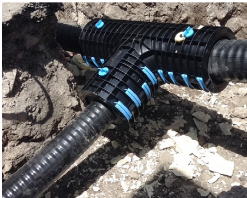
Il guscio a "T" in ABS assicura un perfetto isolamento della giunzione
