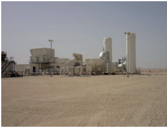
Fig. 3 - Il nuovo sistema autonomo, costituito da un generatore e una turbina a gas, genera elettricità senza interruzione utilizzando il gas associato proveniente dal Gosp a Nakhla (Fonte: Wintershall)
