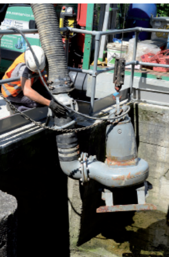
Le pompe NS di Xylem possono essere immerse direttamente senza necessità di ulteriori opere
