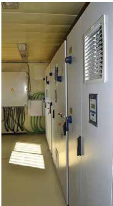
maniera autonoma. Il sistema consiste in un convertitore di frequenza SD700SP in modalità master e un SD500 slave. Entrambi controllano pompe da 18 kW per l'irrigazione di campi di orzo da un bacino idrico nelle vicinanze.
