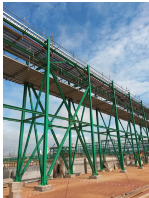
Lavori di costruzione del nuovo impianto di trattamento olio onshore - BOSCONGO (REPUBBLICA DEL CONGO)
