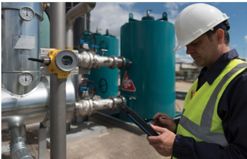
Il nuovo rilevatore di gas fisso Sensepoint XRL monitora l'impianto industriale alla ricerca di particolari gas nocivi, quali monossido di carbonio e metano. A differenza di altri rilevatori di gas fissi, Sensepoint XRL supporta la connessione Bluetooth e pertanto installazione e manutenzione possono essere eseguite in remoto utilizzando un'applicazione per smartphone.
