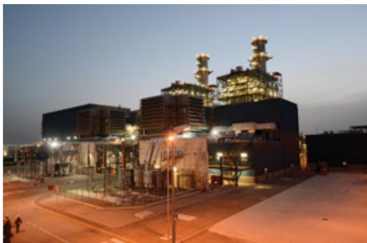
Fig. 1 - Centrale a ciclo combinato da 825 MW a Kocaeli-Gezbe, in Turchia, equipaggiata da due turbine a gas AE94.3A
