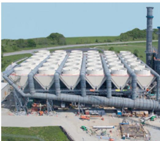
Condensatore ad aria In Air
