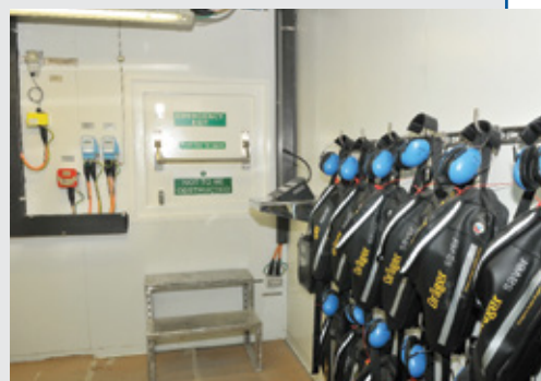
Fig. 2. Installazione offshore, locale emergenza equipaggiato con respiratori personali utilizzati durante l'uscita dal modulo
