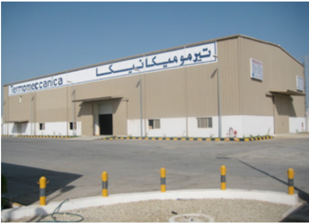
Stabilimento Termomeccanica Saudia Co. Ltd di Al Jubail
