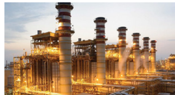
Centrale elettrica a ciclo combinato di Damavand Iran dove le pompe Termomeccanica sono installate
