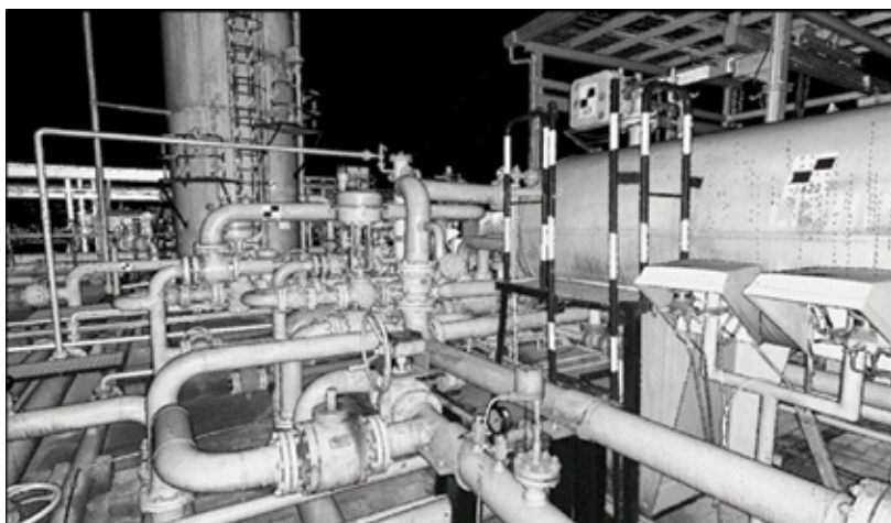
Figura 3: Particolare di "nuvola di punti" da scansione laser
