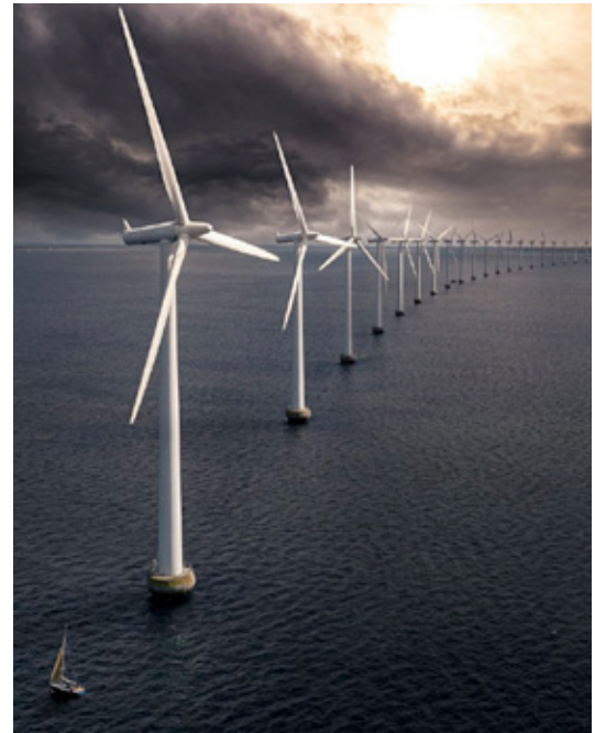
Turbine offshore (NewAtlas, gennaio 2021)
