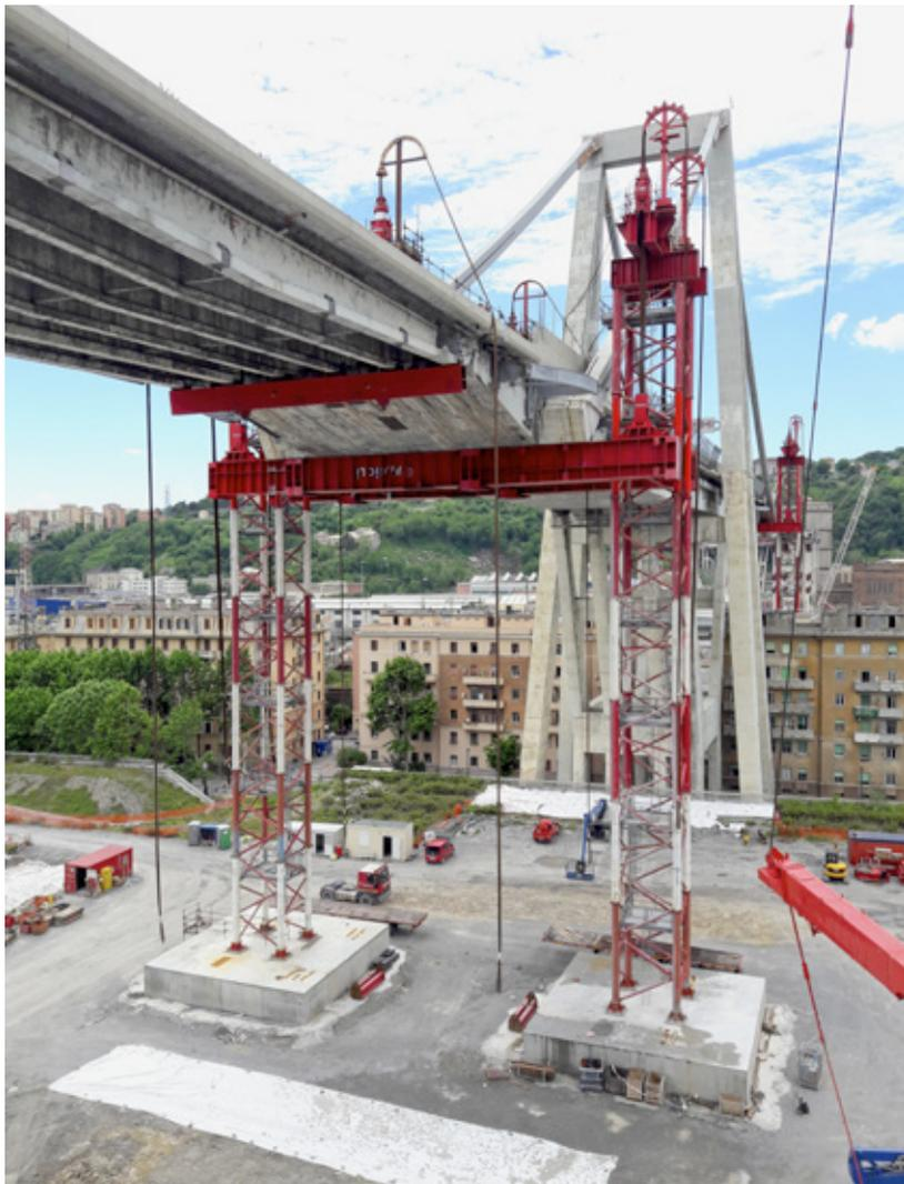
Figura 7 – Messa in sicurezza della pila 10 e 11 mediante torri di supporto tralicciate
