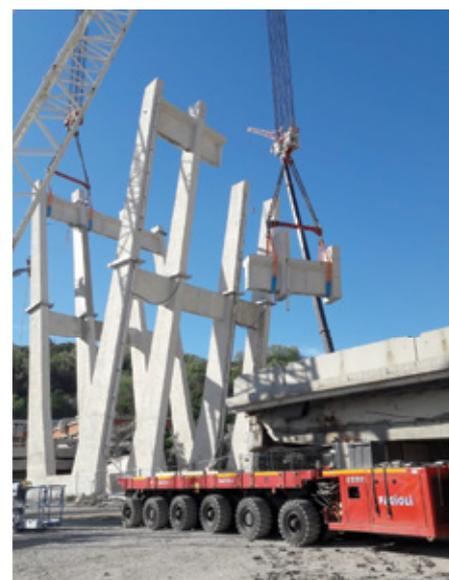
Figura 6 – Smontaggio della pila con gru
