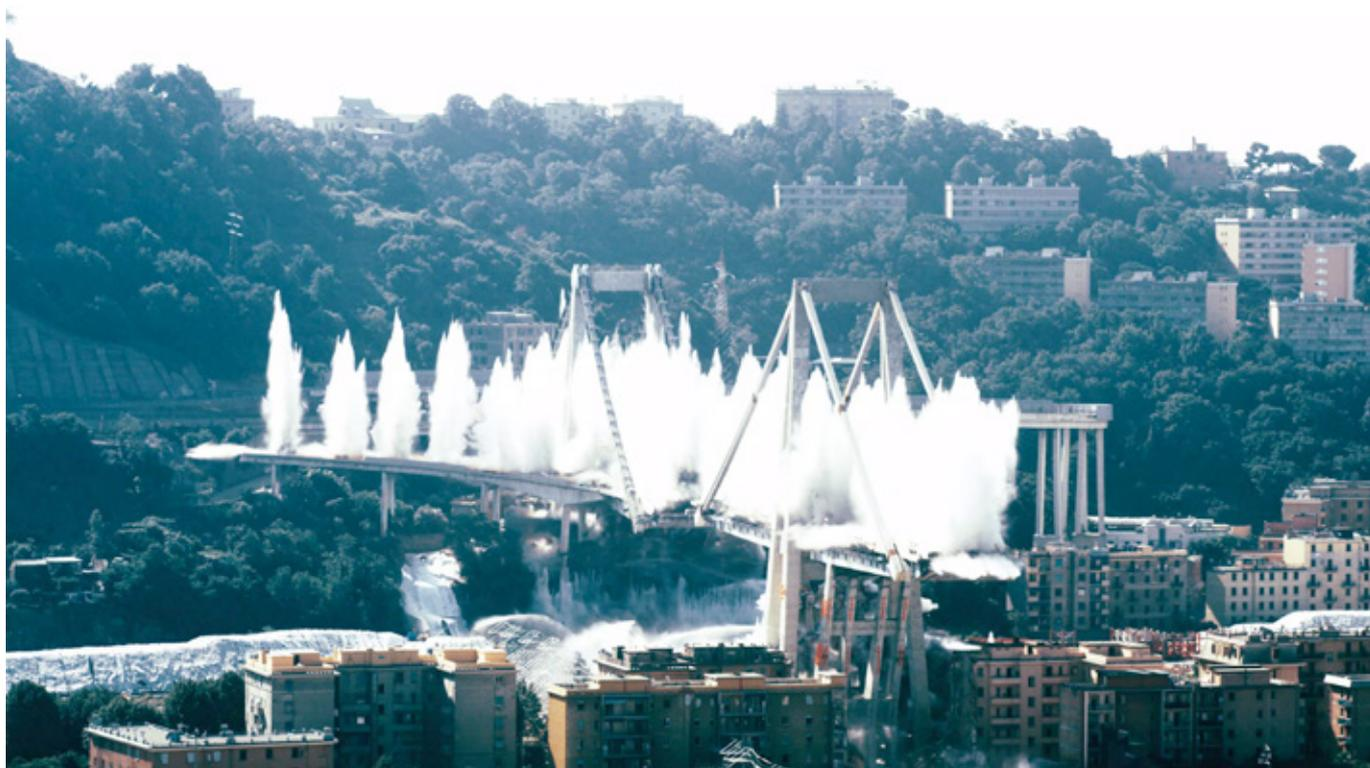
Esplosione controllate delle pile 10 e 11
