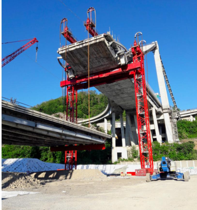
Figura 8 – Abbassamento del tampone 11 compreso tra la pila 10 e 11
