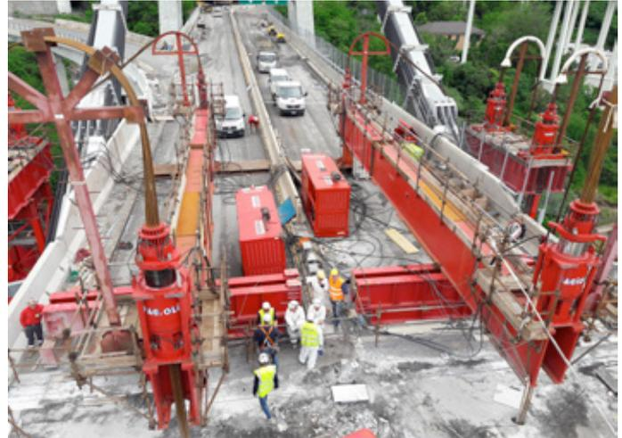
Figura 3 – Abbassamento della trave tampone 7 con il “Fagioli cantilever beam system”
