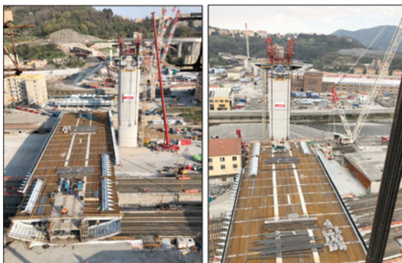
Figura 8 – Movimentazione dell'impalcato 100m in corrispondenza della ferrovia
