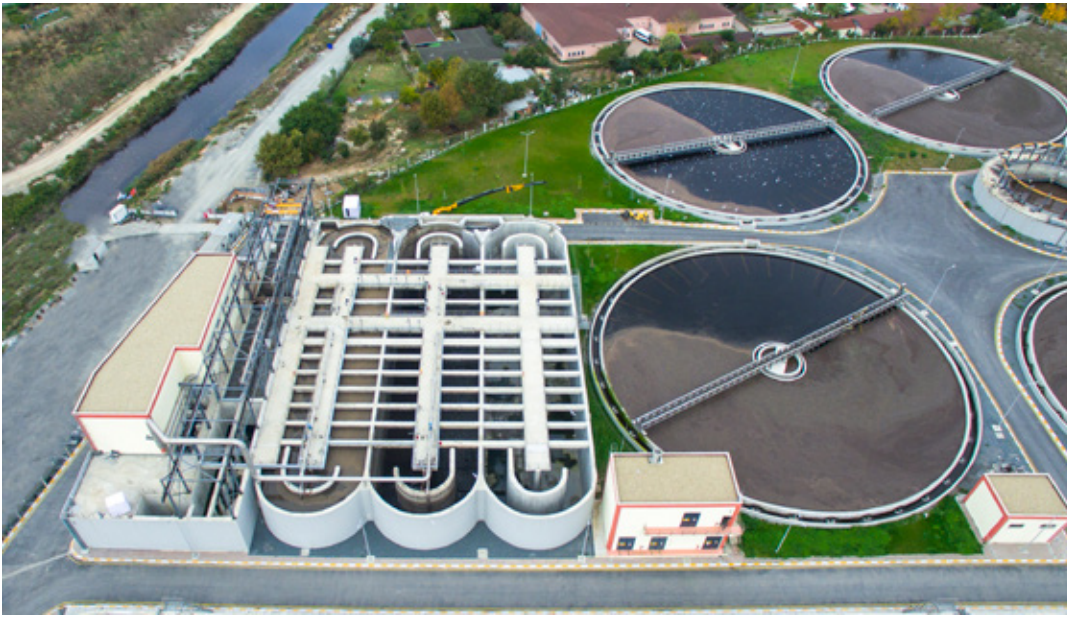
Atakoy Wwtp, Turkey (Fisia Italmimpianti & Alkatas). MBR Plant
