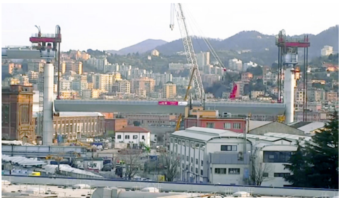
Figura 2 – Sollevamento di una campata L=100m tipica con “Strand Jack System”
