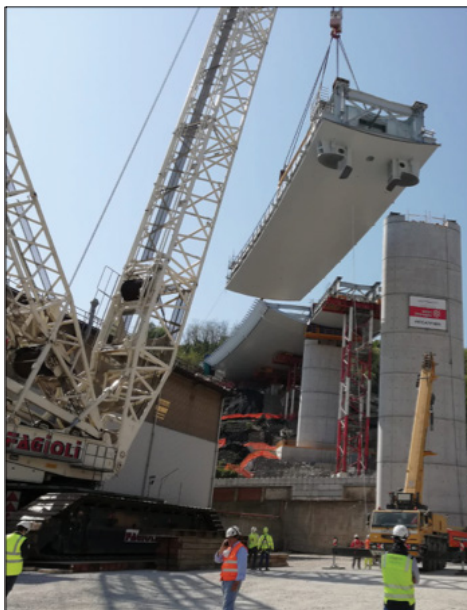
Figura 10 – Sollevamento tipico in singola di un concio con l'ausilio di torri temporanee
