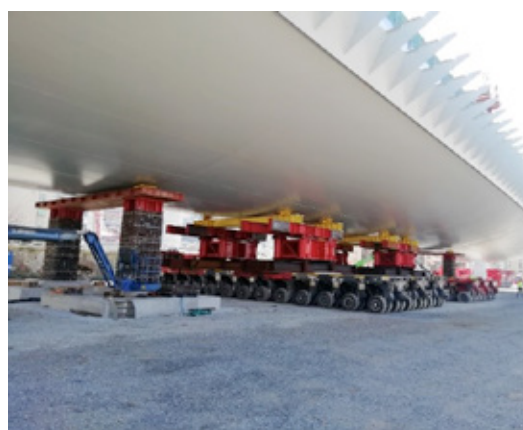
Figura 6 – Sollevamento di 5m dell'impalcato e inserimento dei mezzi di trasporto
