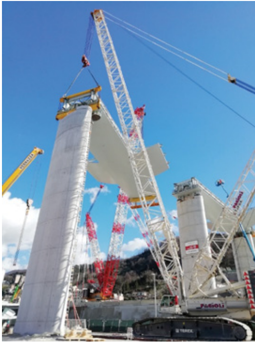
Figura 9 – Sollevamento tipico in tandem della campata 50m
