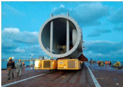
Vari step di traslazione laterale del reattore e relativo ballastaggio - Ortona
