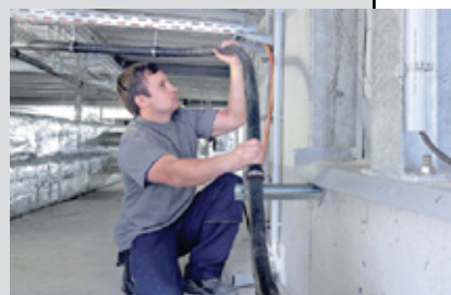
Una fase di montaggio della condotta
