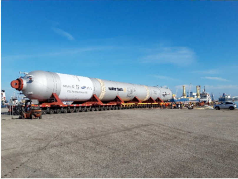
Convoglio in posizione per inizio attività di load-out su chiatta - Ortona
