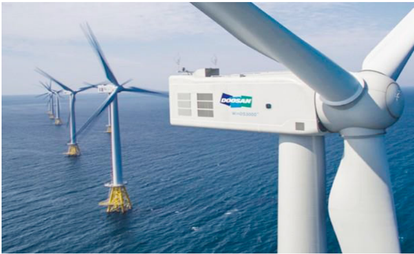
Figura 1 - Turbine eoliche WinDS3000
