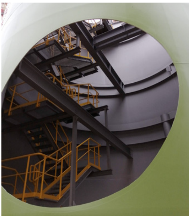
Sezione di interno della ciminiera
