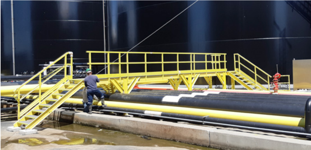
Dettaglio camminamento in PRFV su piattaforma estrattiva
