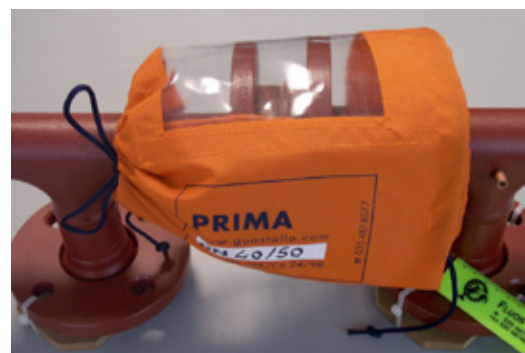
Copriflange "PRIMA" su acido cloridrico - industria farmaceutica
