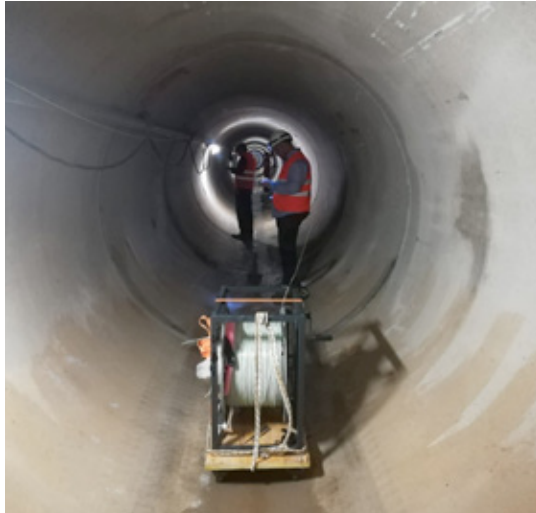
Fig.6 - Bobina di avvolgimento dei cavi in fibra (a sinistra) e installazione completata del cavo sensing (a destra)
