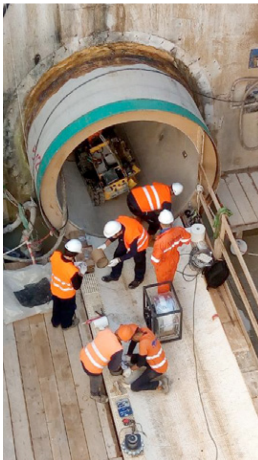
Fig 5 - Preparazione del trattore elettrico per posizionamento clampe e mensole di supporto
