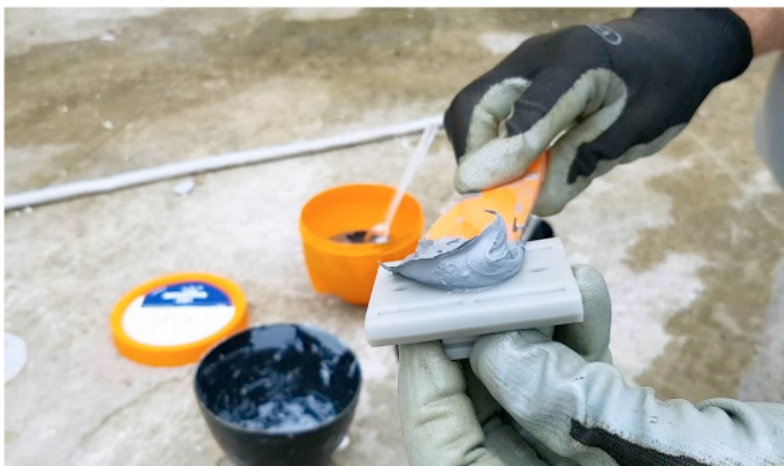
Fig. 3 - Applicazione della resina bi-componente sulla mensola di supporto
