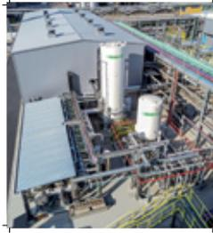
Impianto SMART TB-LNG per la re-liquefazione del BOG. Per gentile concessione di DIG - Depositi Italiani GNL, Ravenna
